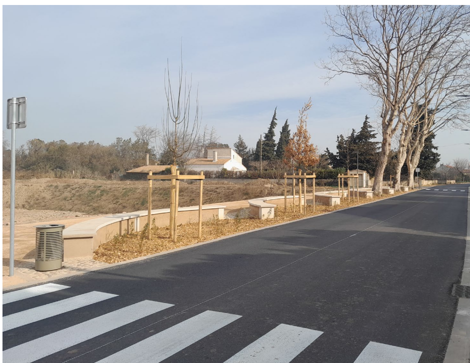
Vue 2 : Construction de murets en béton de terre
